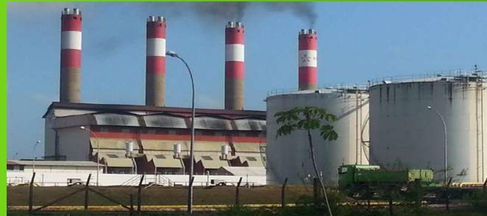
La centrale EDF de Dégrad des Canes, sur le port du même nom, à Remire-Montjoly, fournit le réseau de Cayenne ; elle a une puissance de 112 MW, composée de 9 moteur à combustion de 8 MW unitaire et de deux turbines à combustion d'une puissance de 20 MW chacune ;
